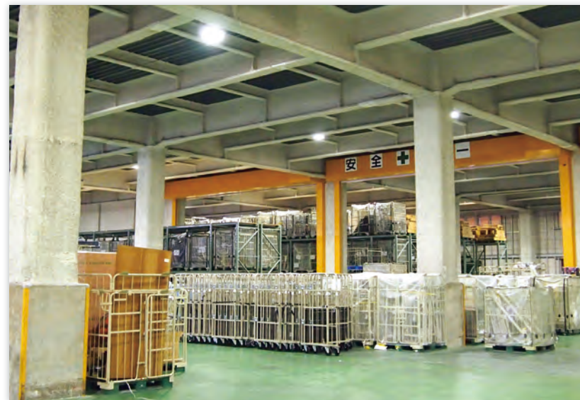
■ 大阪メンテナンスセンター保管倉庫
